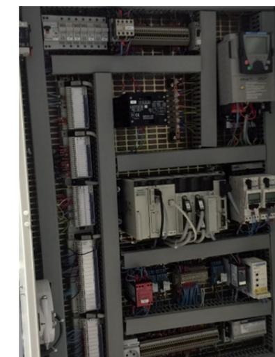
Armoire électrique gérée avec Automate Premium. Le déplacement de l'axe permettant le transport des flacons dans les cartons est assuré par moteur asynchrone piloté par un Altivar 71. La gestion de la position de l'axe est assurée par une carte de comptage rapide et un codeur incrémental.
