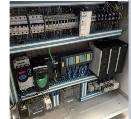
Armoire électrique gérée avec Automate ET200SF-CPU. Cet automate gère la sécurité et le process de l'installation. La gestion de la température est assurée par un gradateur à angle de phase et un régulateur de température. Les moteurs de la soufflerie et du convoyeur sont équipés de variateurs de vitesse.
