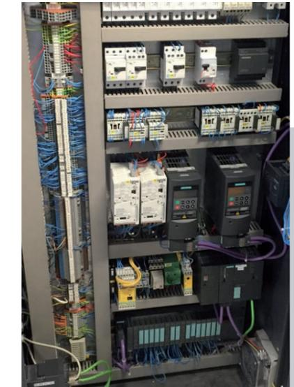
Armoire électrique gérée avec Automate S7300. Les convoyeurs d'entrée et de sortie sont gérés par des moteurs asynchrones pilotés chacun par un Micromaster 420 communiquant en Profibus DP. Réseau de communication Profibus DP et Profinet.
