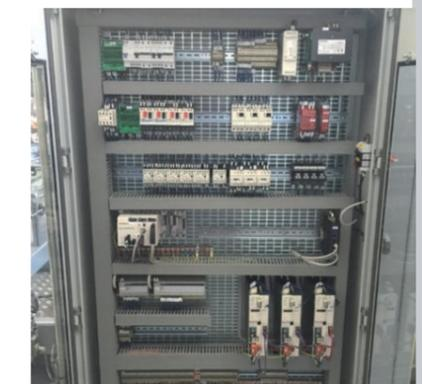
Armoire électrique gérée avec Automate M340. Le déplacement des axes X, Y et Z sont gérés par des moteurs Brushless pilotés par variateurs. Ces variateurs sont contrôlés par un réseau Canopen. Sur ce réseau on trouve également des entrées et sorties déportées. La machine dispose d'un réseau Modbus TCP pour la communication entre l'automate M340 et le pupitre tactile. Réseau Canopen et Modbus TCP.
